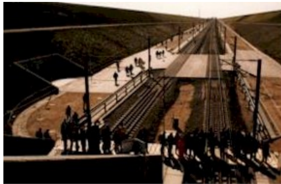
Alt jord omkring nedkørslen til tunnelen er opfyldt fra den borede del af havbunden. Tunnel åbningen er 12 meter under havets overflade.
