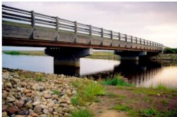
Broen her nær Lønborg, ved Skjernåvej, er en af de to vejbærende broer, der er udført som træbro.
