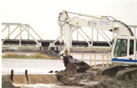
Vandet fik frit løb. Vandstanden i den nuværende Skjern Å vil falde. Entreprenøren lægger derfor spærring ud, så al vandet presses over i de nye, oprindelige slyngninger.
