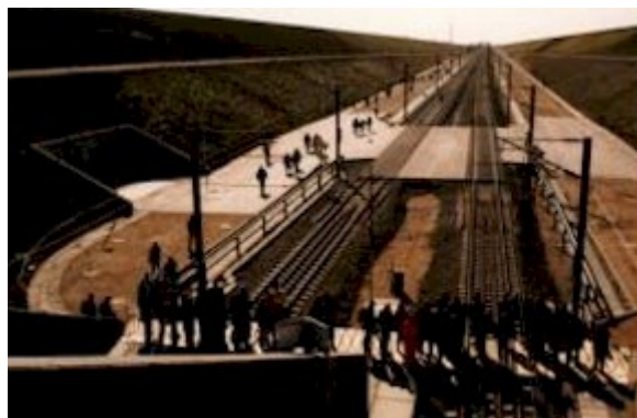
Alt jord omkring nedkørslen til tunnelen er opfyldt fra den borede del af havbunden. Tunnel åbningen er 12 meter under havets overflade.
