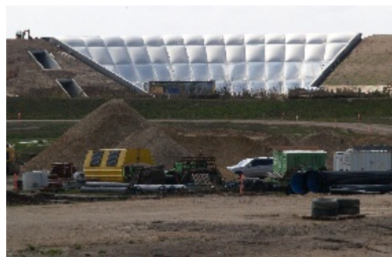
Hele anlægget er placeret på et ca. 45 hektar stort område i udkanten af Ringkøbing. Parken består af en stor ringvold på ca. 30.000 m 2 , med en integreret hovedbygning på knap 3.500 m 2 .
