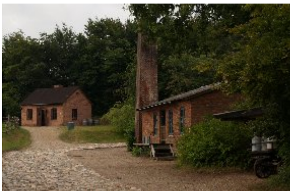
Mejeriet fra Mandø, der er Danmarks mindste, er bygget i 1897. Det er fuldt monteret med maskiner, således at der kan fremstilles almindelige mejeriprodukter. Dampkedlen er en kornisk kedel fra 1898, der stammer fra Sulsted Mejeri.
