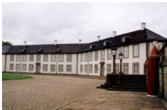
Fredensborg Slots hjørnepavillon, tilført slottet 1753 - 54. Til højre: Hovedtrappen op til slottet.
